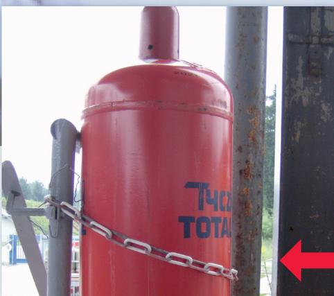
Entleerte Flaschen dürfen immer nur mit Schutzkappe und Verschlussmutter abgestellt werden und sind gegen Umfallen zu sichern. Das Ventil muss stets zugedreht sein.
